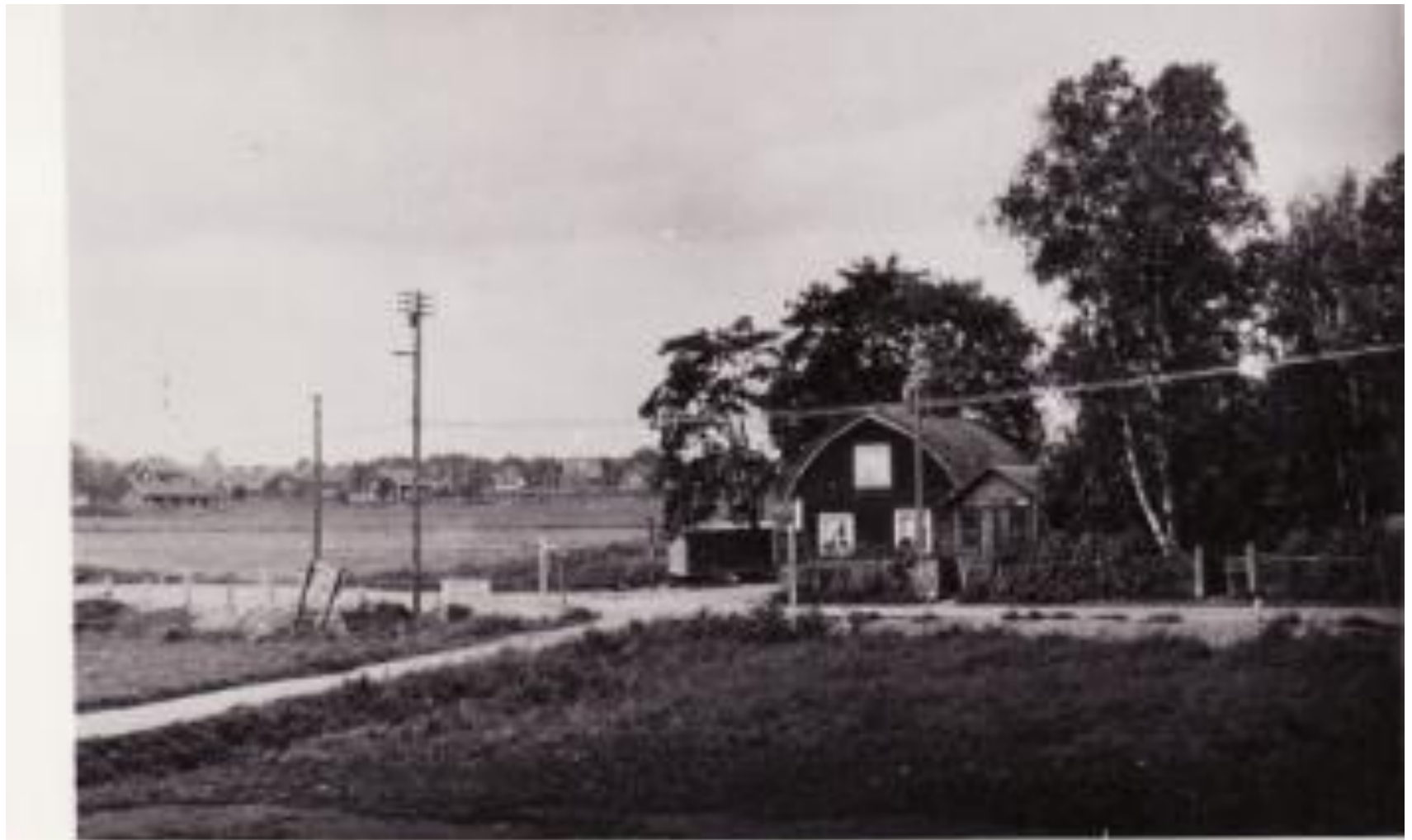
Grindstugan vid Älvsjö millé och Huddingevägen R 83 01 1050 1050
